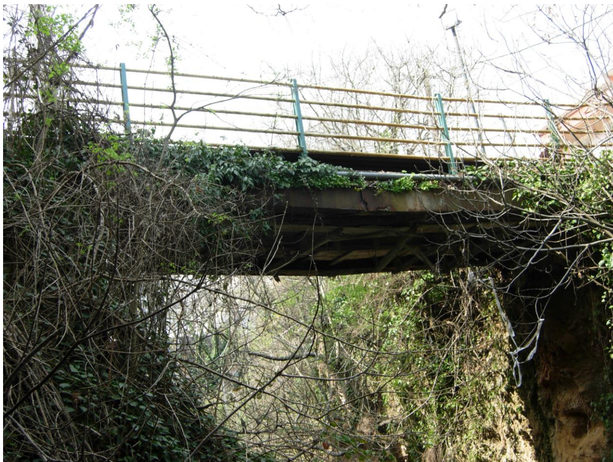
Φώτ. 2: Άποψη τεχνικού οδού Ολγάνου
