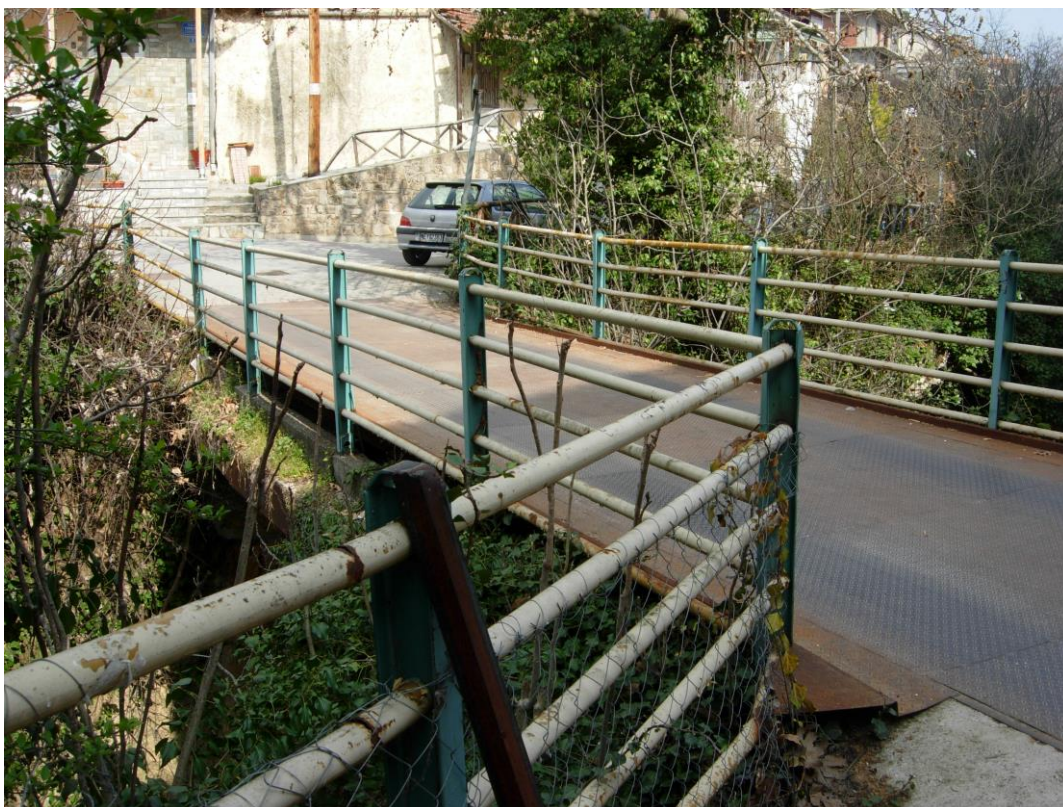
Φώτο 1: Άποψη κατασρώματος γέφυρας οδού Ολγάνου
